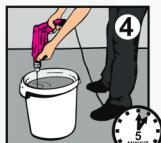
Перемешайте раствор дрелью со специальной насадкой на низких оборотах, засыпая сухую смесь в воду до получения однородной массы. Подождите 3-5 минут, после чего перемешайте раствор вторично. Время пригодности раствора к работе - 3 часа. При температуре воздуха до -10°C раствор находится в рабочем состоянии не менее 30 минут.
