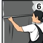
В случае необходимости применения штукатурных маяков, установите их параллельно друг другу на расстоянии 15-20 см меньше длины правила. Набросайте штукатурку мастерком или нанесите кельмой слоем от 2 до 30 мм. При механизированном нанесении приготовленный раствор наносят методом машинного набрызга. Нанесенный слой разровняйте с помощью кельмы или правила.
