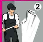
Обработайте основание грунтовочными составами БОЛАРС, соответствующими вашему типу поверхности. При нанесении на цокольную часть фасада необходимо обработать поверхность грунтов БОЛАРС Sil-primer или Sil-primer Quartz для повышения влагостойкости основания.
