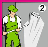
**2** Обработайте основание грунтовыми составами БОЛАРС, соответствующими Вашему типу поверхности.
