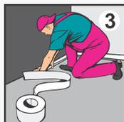
**3** Для получения аккуратного шва рекомендуется защищать лицевые кромки конструкции малярным скотчем. Для формирования глубины нанесения герметика шов уплотняется эластичным жгутом из вспененного полиэтилена. Жгут помещают в шов таким образом, чтобы обеспечить соотношение глубина шва/ширина шва = 1/3 или 1/4, но не менее 3 мм, для швов шириной до 15 мм. На более широких швах толщина нанесения герметика должна быть не менее 5 мм.
